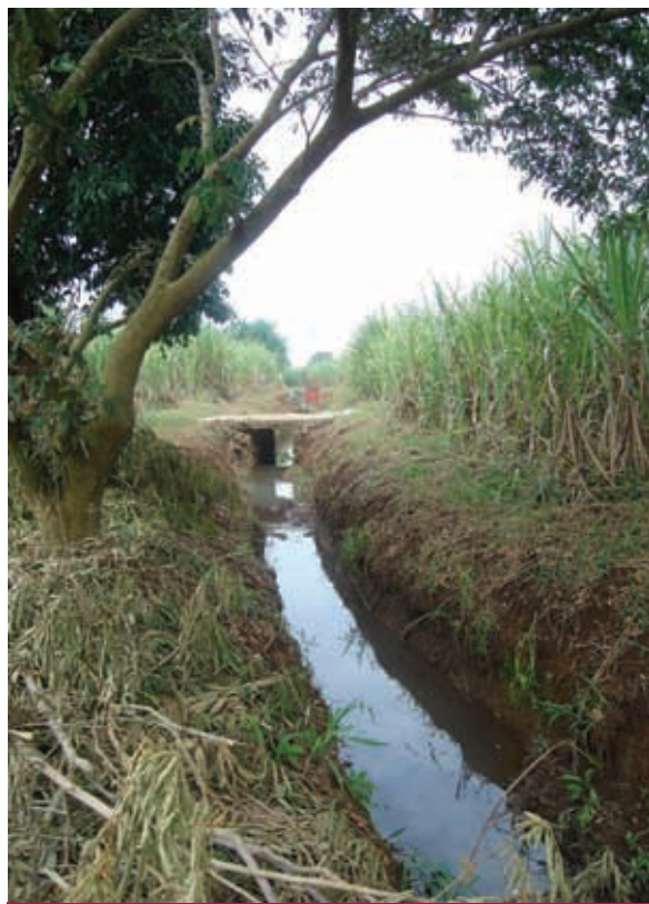
FIGURA 3. En el campo cañero veracruzano prevalece un sistema de riego ineficiente que distribuye el agua a través de canales a cielo abierto, generalmente sin ningún tipo de revestimiento (Foto: Gabriel Mercado, en la región de Córdoba, Veracruz).
